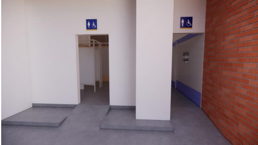
Vista exterior módulo de baños 1er nivel edificio CM-2
