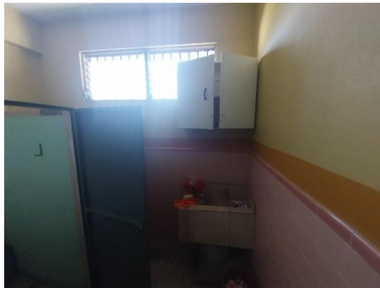
Fotografía N° 2. Vista interior, BAÑOS MUJERES 3ER NIVEL
